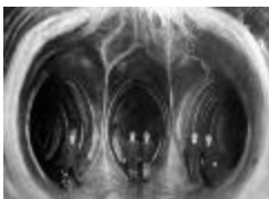
Catskill Aqueduct (NYS_A3045-78_P8498)
